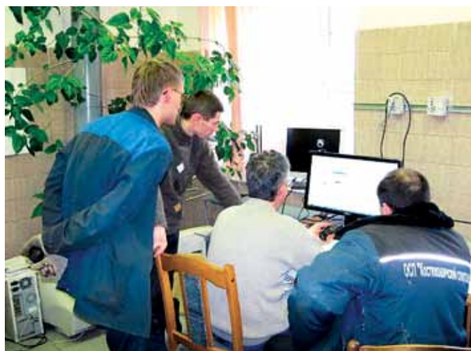
Выполняется наладка автоматики
